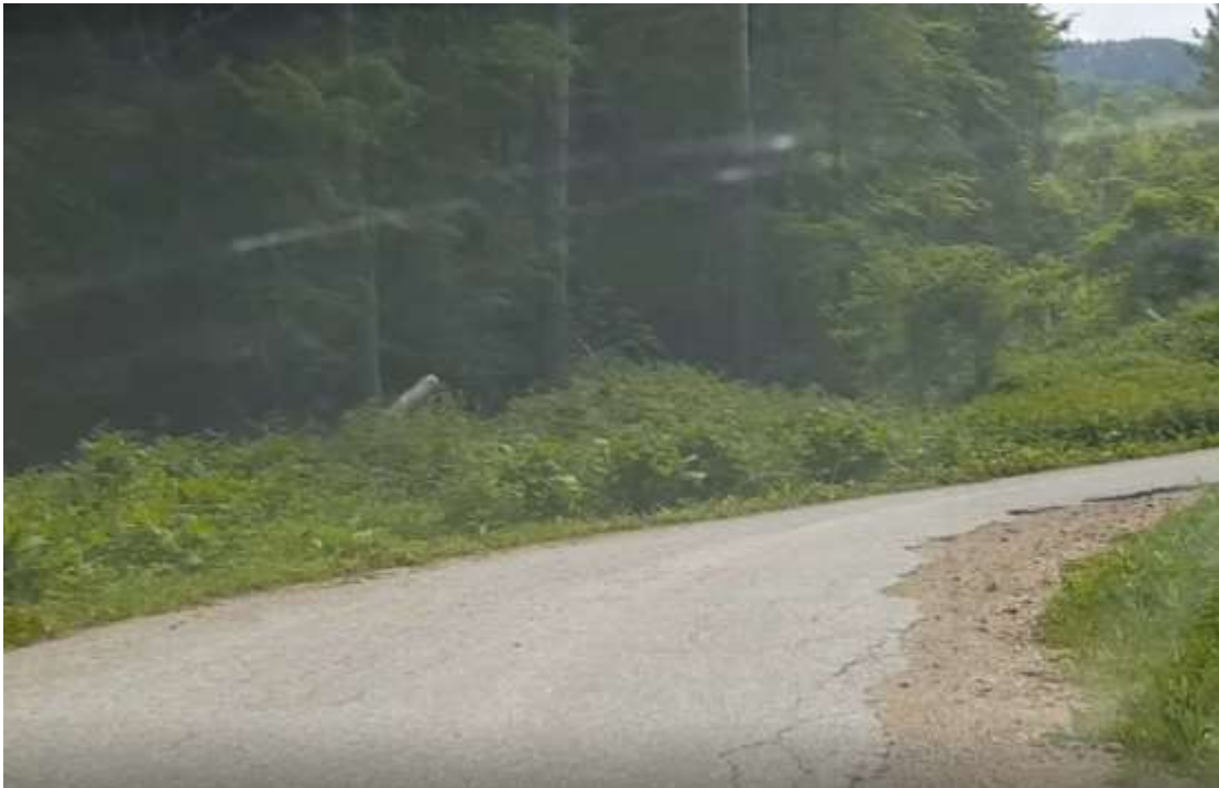
Fotografia 3 (Gjendja e rrugës ekzistuese lokale)
