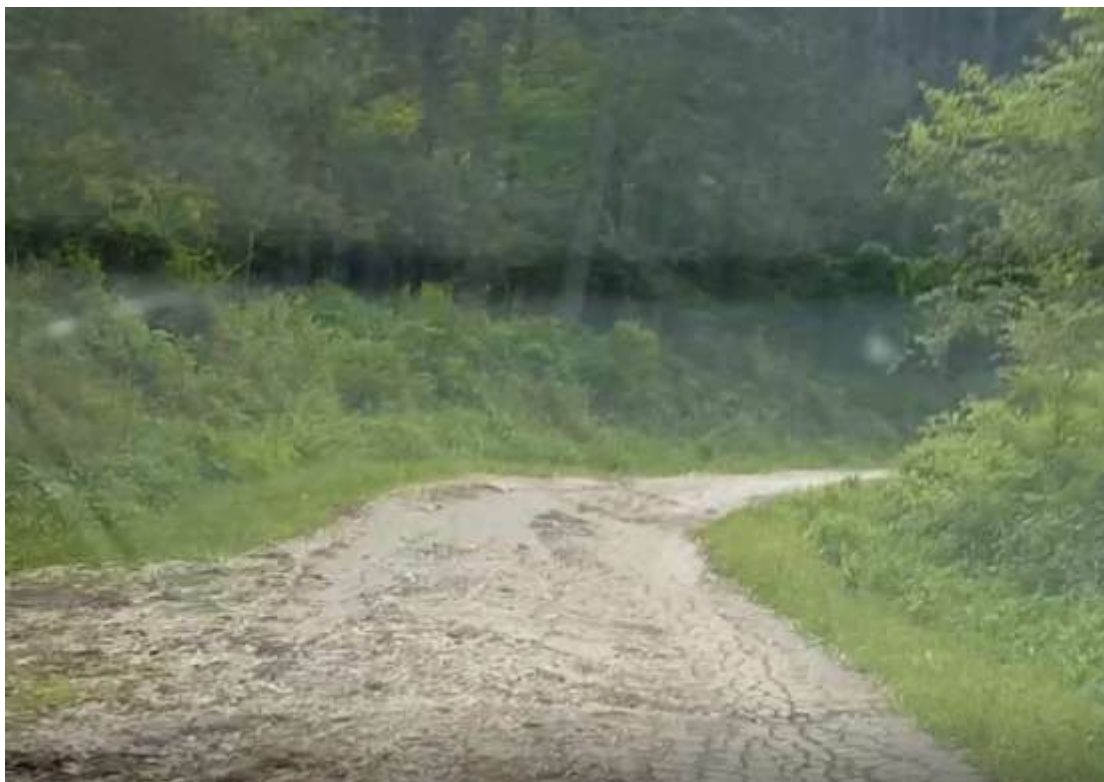
Fotografia 4 (Gjendja e rrugës ekzistuese lokale)
