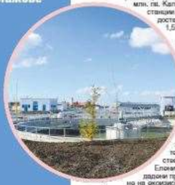
Пречиствателната станция в Русалка е най-голямата по България. Снимка: Елена Фотала
