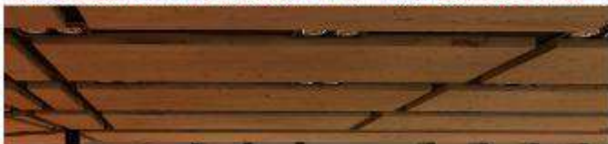
CEILING CLADDING WITH HPL / ОБЛОЖУВАНЕ НА ПЛАФОН СО СПЛЕМЕНЕТА ИВЕРКА
